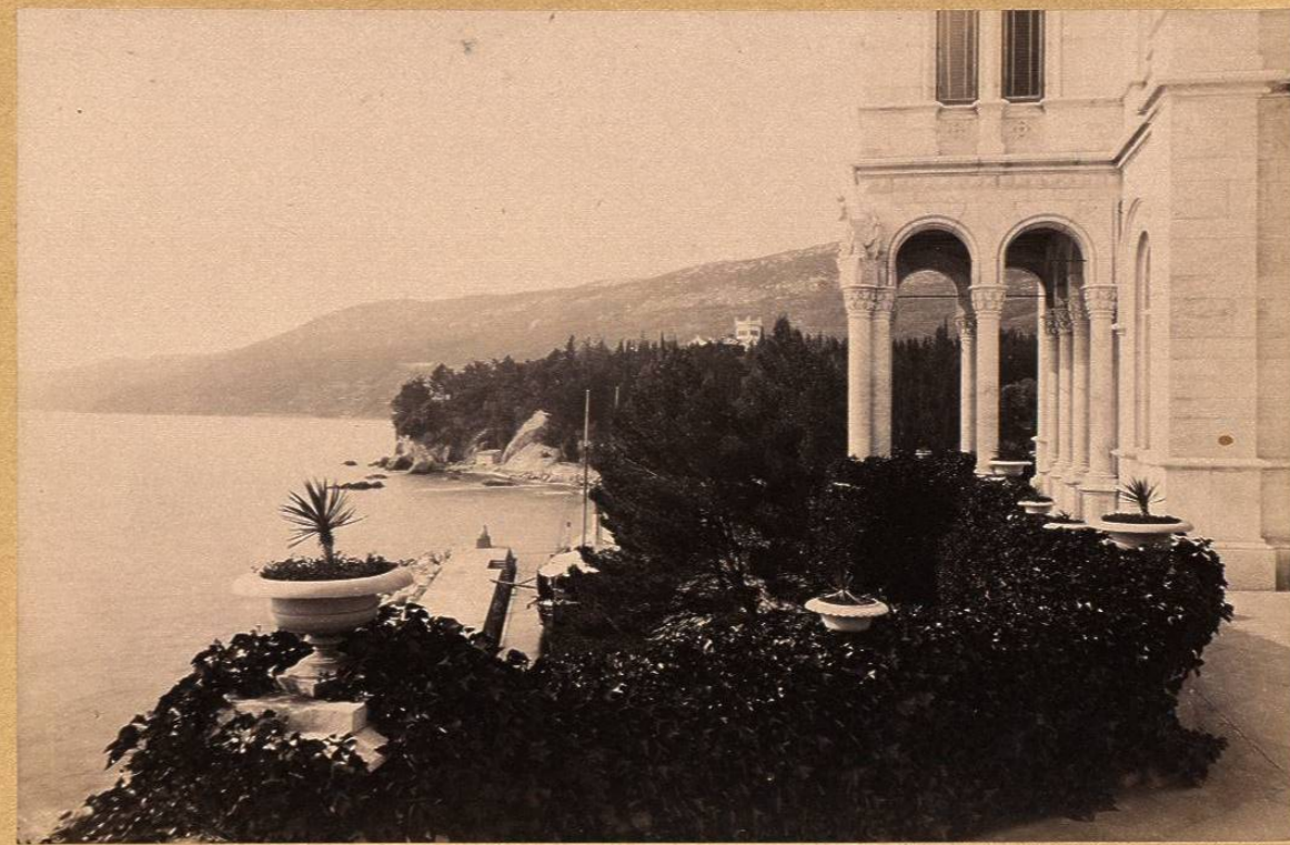
LE BALCON COUVERT DE LA TERRASSE DU CHÂTEAU.
