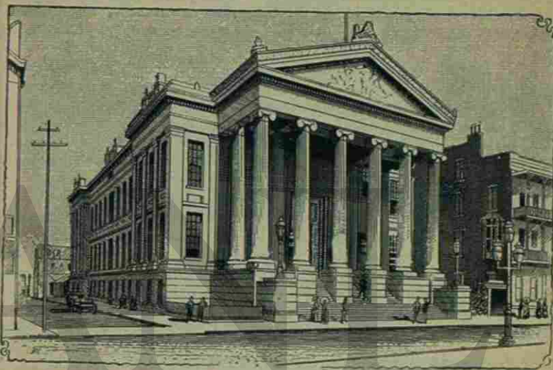
CASA DEL AYUNTAMIENTO—Nueva Orleans.
