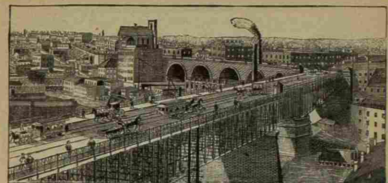
Gran Viaducto Central—Cleveland.
