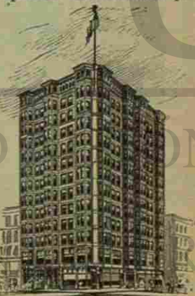
EDIFICIO TACOMA—En las calles La Salle y Madison, de 13 pisos.
