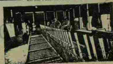
VISTA INTERIOR DE LA MISMA TORRE.
