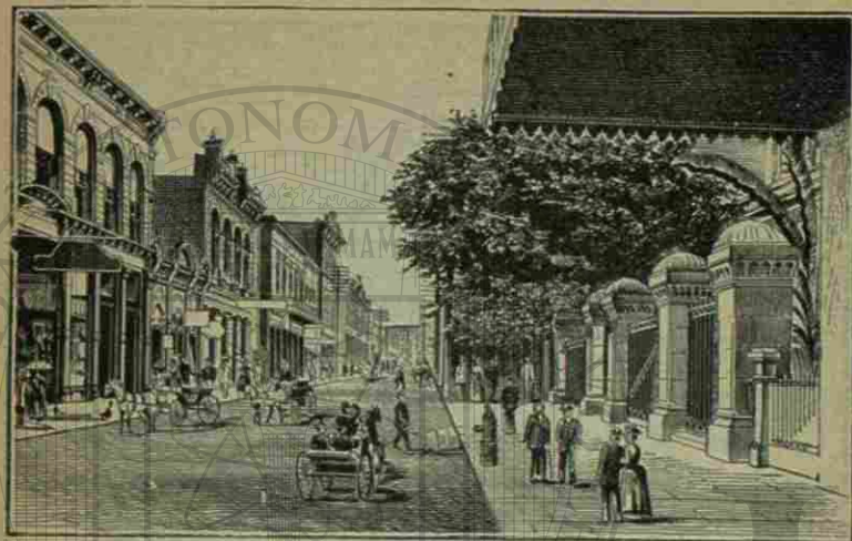
CALLE DEL COMERCIO, SAN ANTONIO, TEXAS.—Ferrocarril Internacional & Gr at Northern.
