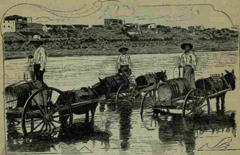
OBRAS HIDRAULICAS—Nuevo Laredo, Mexico. [Ferrocarril Nacional Mexicano.]
