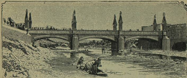
PUENTE DEL COECILLO—Leon, Mexico.
