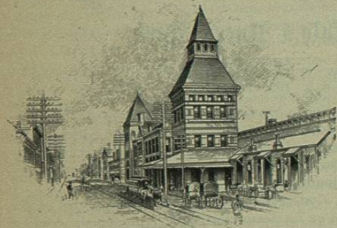
Estacion del "New York Central & Hudson River" en la Calle Exchange—Buffalo.
