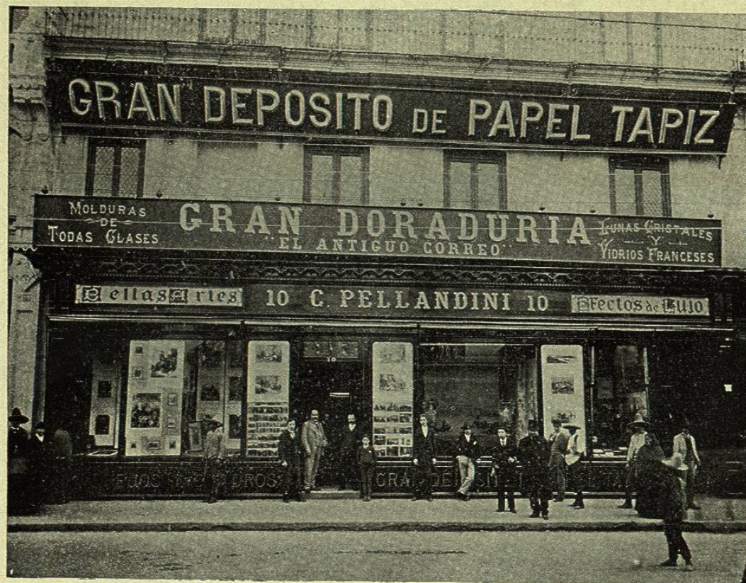
FÁBRICA DE ESPEJOS Y DORADURÍA DE C. PELLANDINI. — DESPACHO EN LA CALLE PLATEROS
