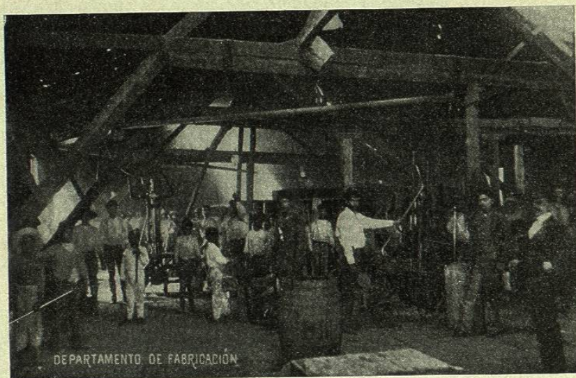
INTERIOR DE LA FÁBRICA DE VIDRIO
