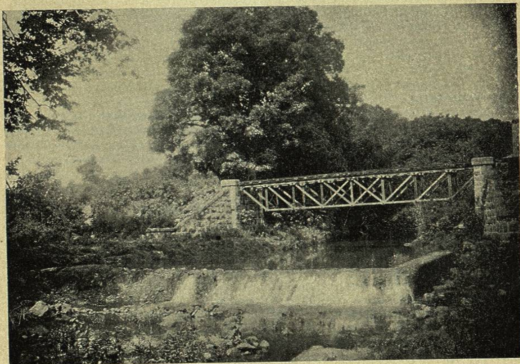
LA SEDEÑA, PUENTE EN EL FERROCARRIL INTEROCEÁNICO
