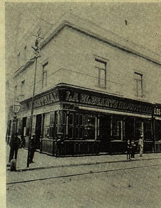
DESPACHO DE LA FÁBRICA DE CALZADO
