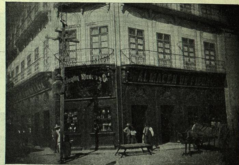
EXTERIOR DE LA FERRETERÍA Y MERCERÍA DE V. ELCORO Y C. a , SUCEORES
