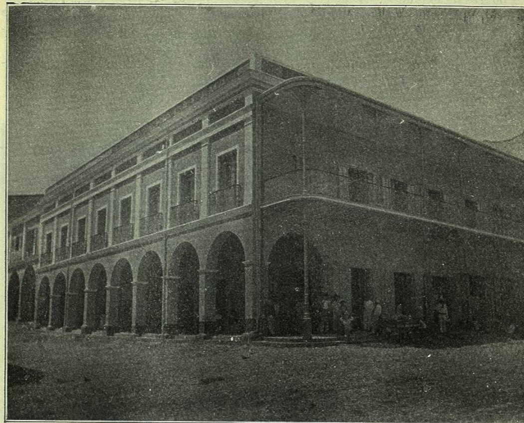
EDIFICIO DE LA FERRETERÍA LA FAMA
