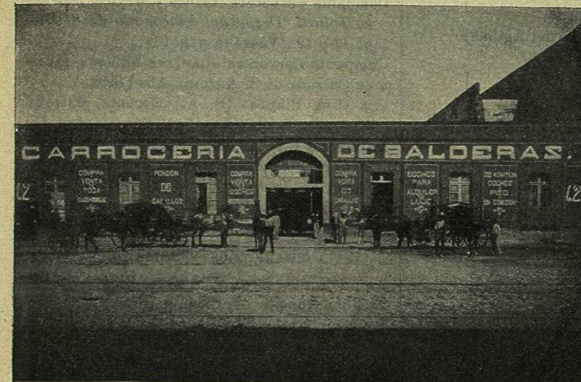
Vista de la Carrocería Balderas
