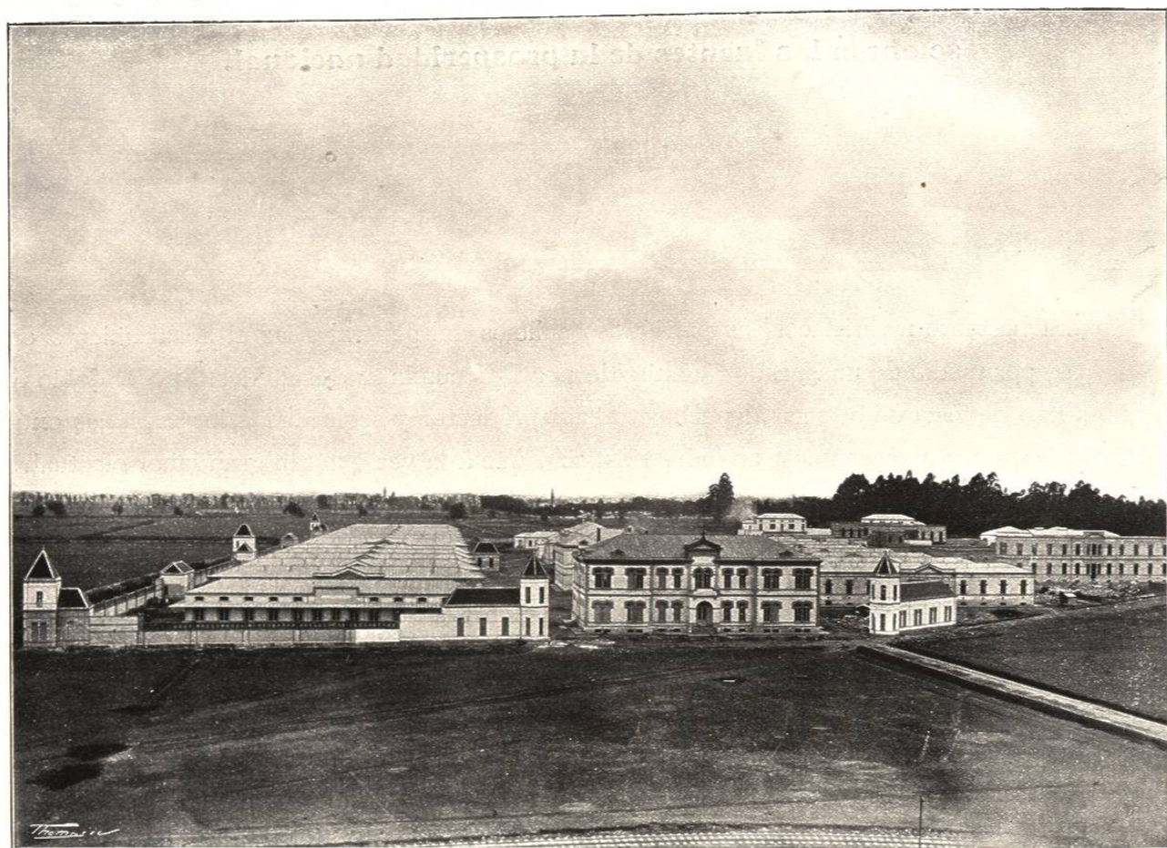
HOSPITAL GENERAL DE LA CIUDAD DE MÉXICO
