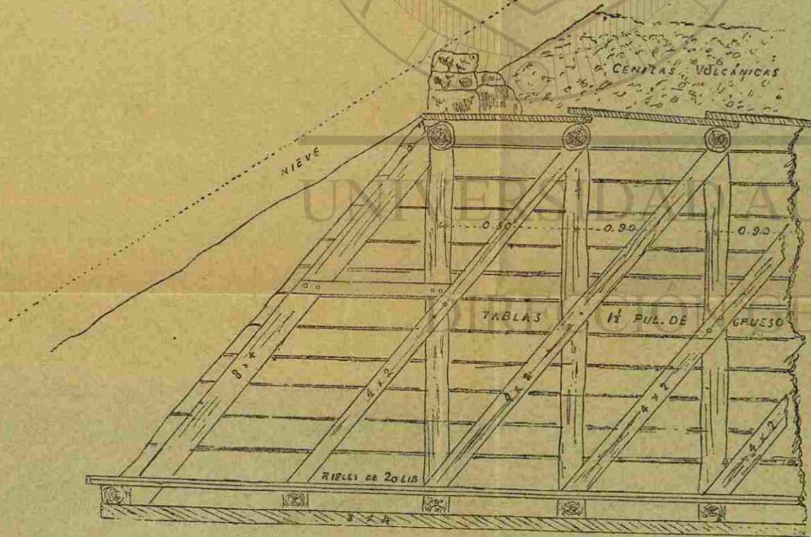
CORTE LONGITUDINAL A LA ENTRADA DEL TUNEL
