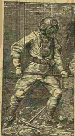
Ouvrier, revêtu d'un scaphandre, travaillant sous l'eau.
