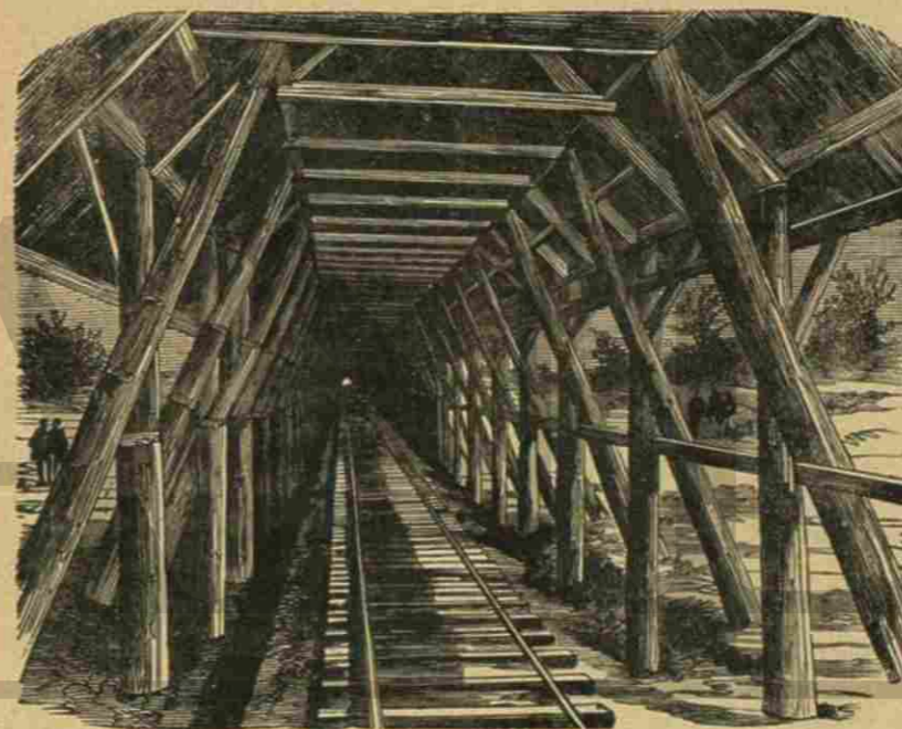
Toit à neige pour abriter les trains.
