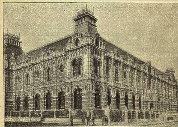
Depósito de las aguas corrientes
