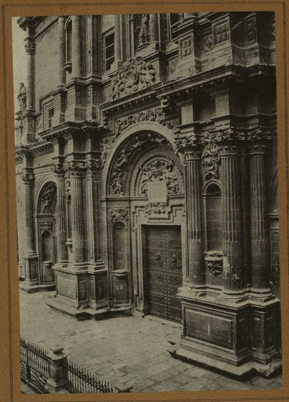
LORCA. — Detalle de la fachada de San Patricio
