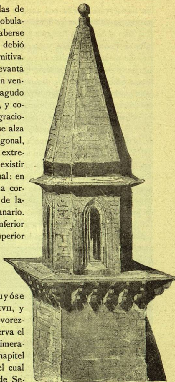
TUDELA.—CATEDRAL.—TORRE DEL EXTREMO S. O. DE LA FACHADA
