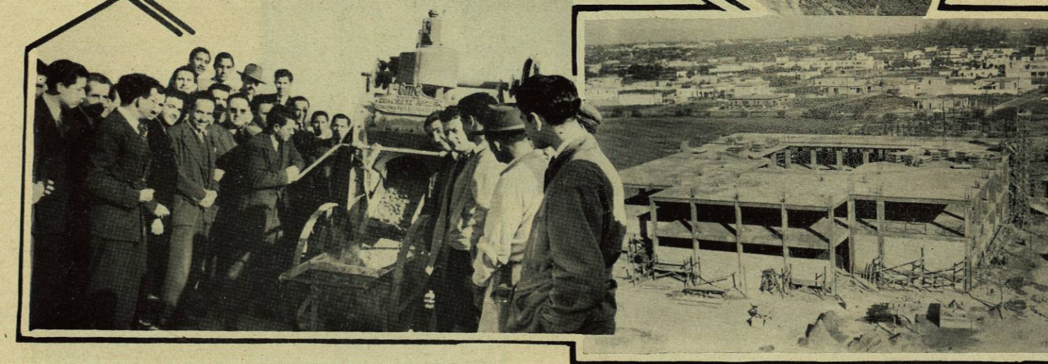
El Gobernador del Estado Lic. Arturo B. de la Garza y el Director de la Facultad Dr. Roberto Treviño Martínez en la colocación de la primera piedra del actual edificio y vistas de su desarrollo.
