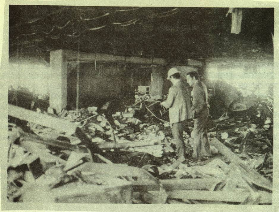
Fig. 9.- Un piso típico después del incendio.
