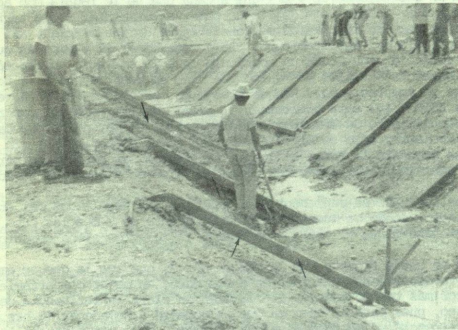
Fig. 16.- Colocación de cerchas para el afine.
