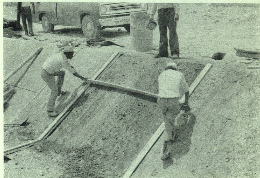
Fig. 17.- Colado con lodo para hacer el afine y rellenos de la sección.
