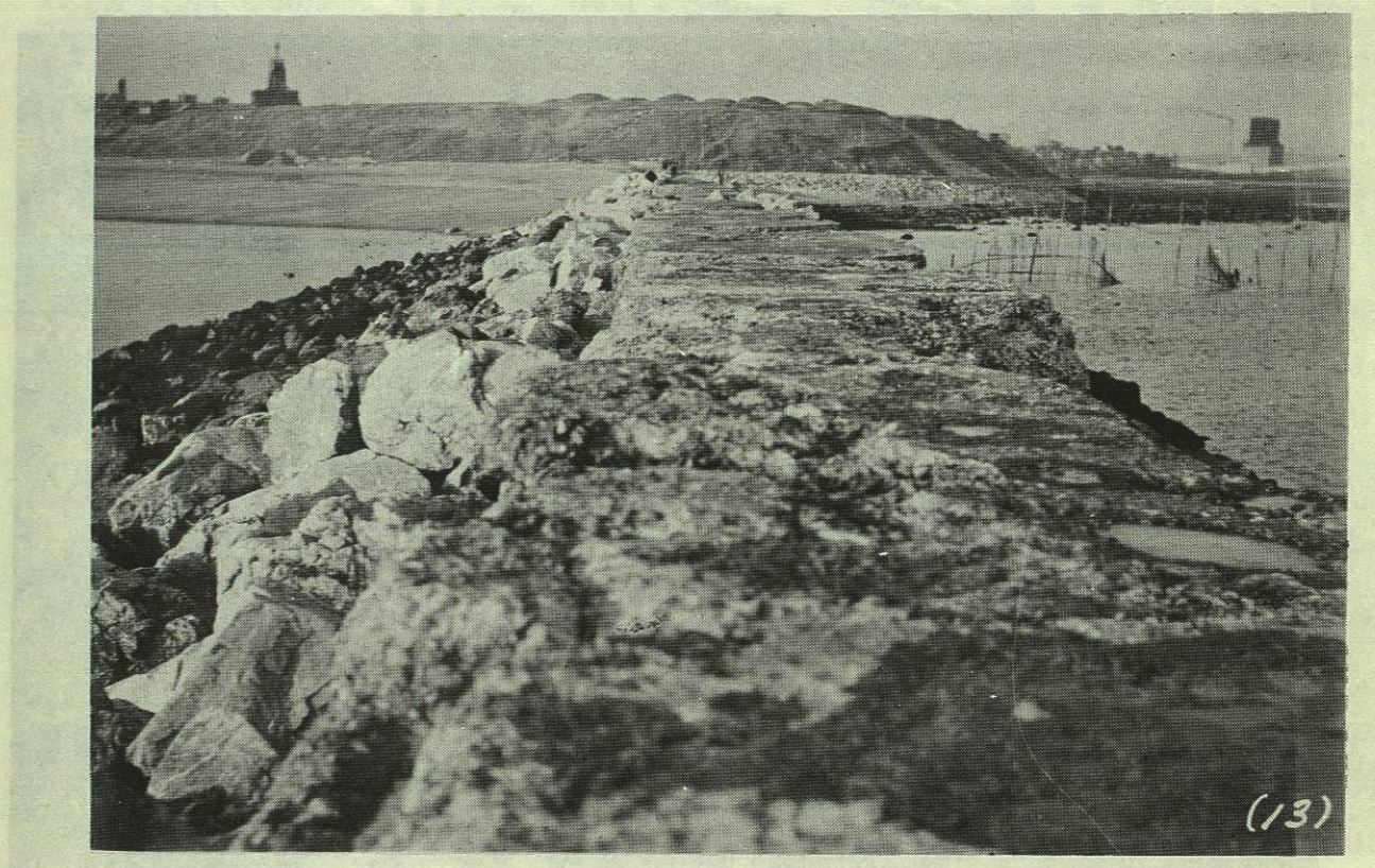
Fig. 1.- Vista en planta - Rompeolas de Negro Point - Foto 1936 Proyecto de Reparación 1905-1910 - Cemento Portland Im portado
