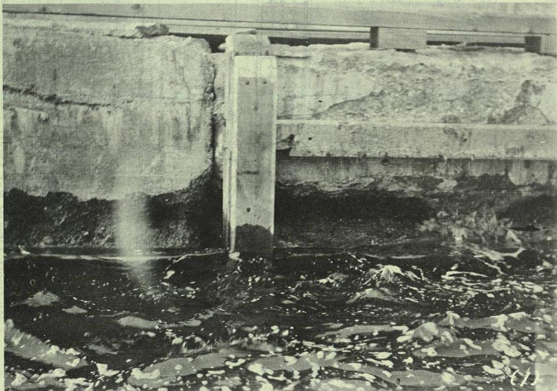
Fig. 6.- Efecto del oleaje sobre el malecón. Puerto St. John, N.B.
