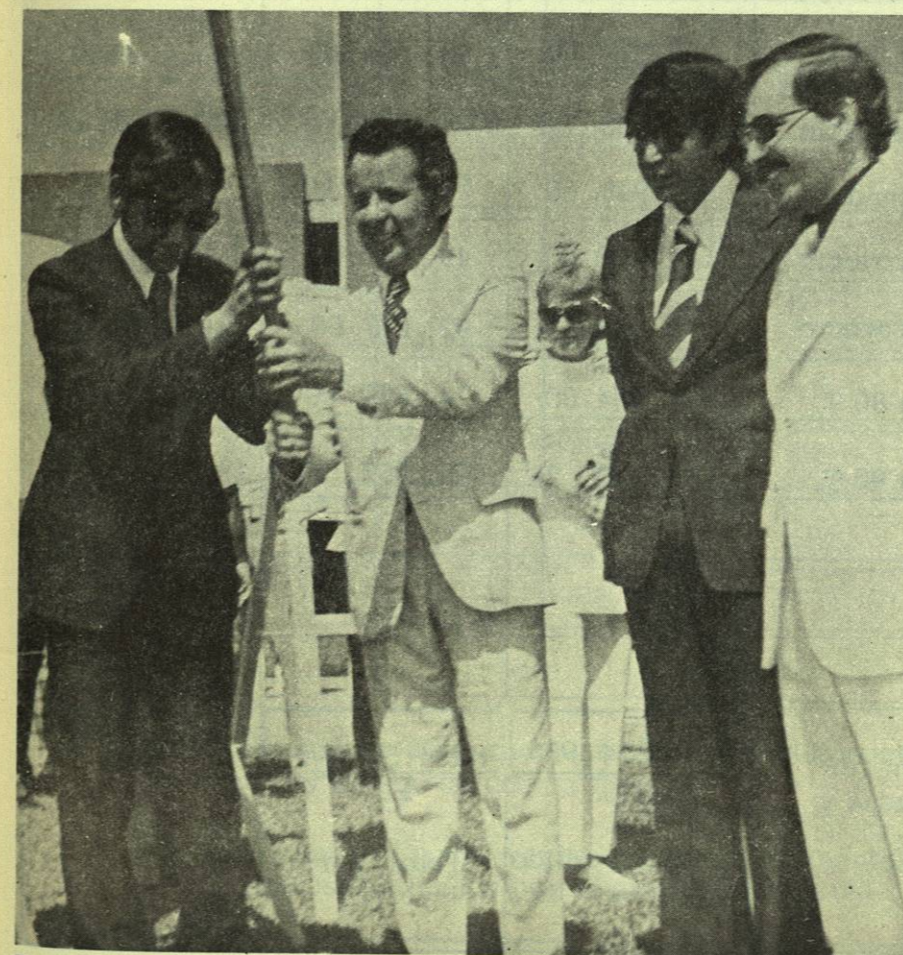
En la Facultad de Psicología, el Rector, Dr. Luis E. Todd y el Gobernador Pedro Zorrilla, dan el primer zapapicazo para las obras que están en marcha en ese plantel.
