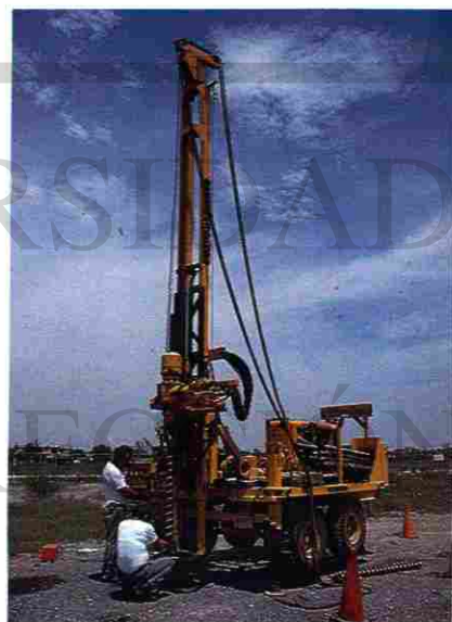
Perforadora, Instituto de Ingeniería Civil.
