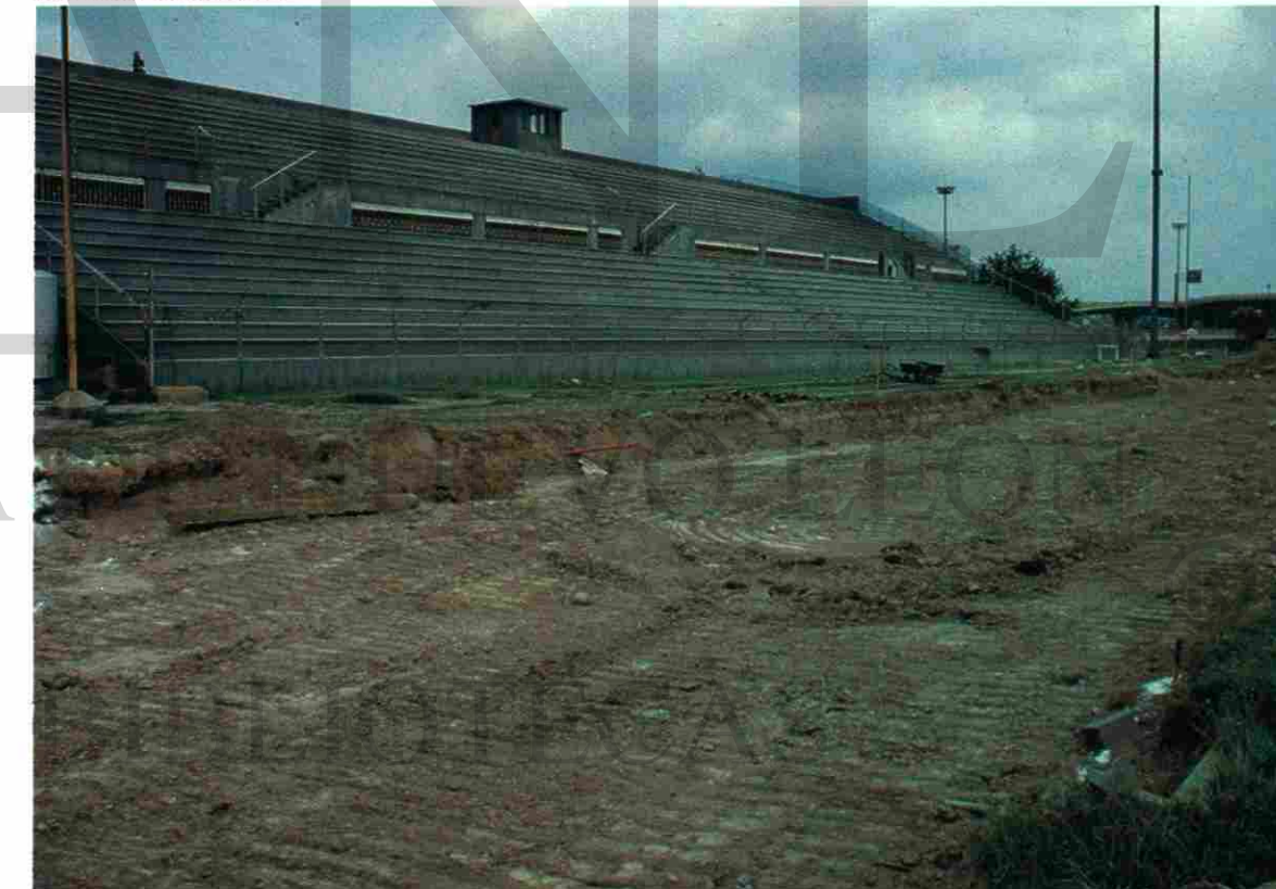
Construcción de pista de tartán, Estadio "Chico Rivera". Ciudad Universitaria.
