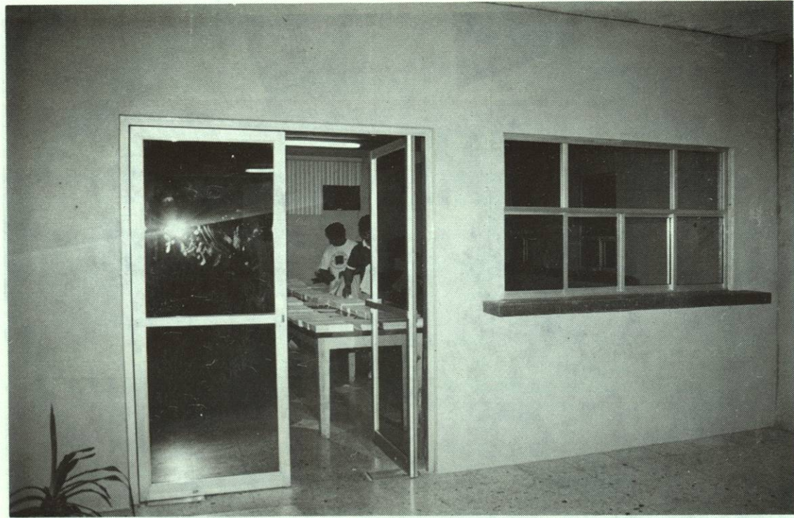
Construcciones y remodelaciones a diversas áreas del Edificio de
