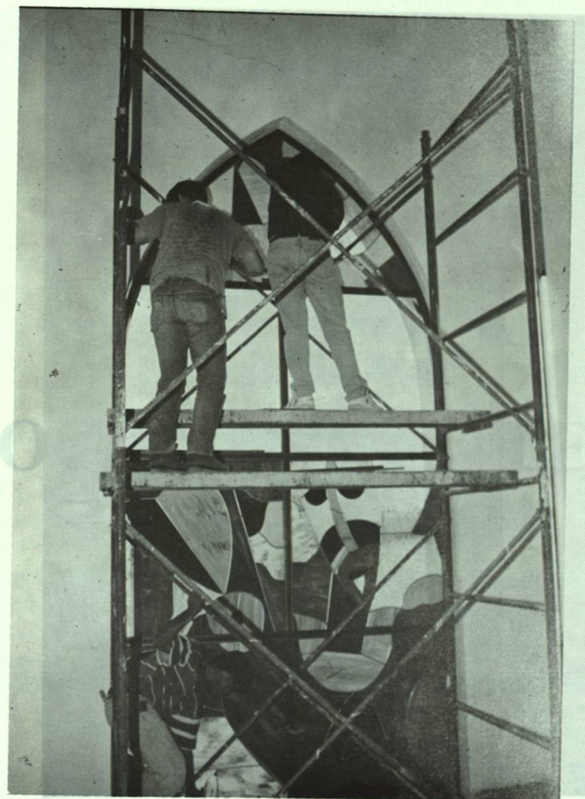
Aspectos de instalación del vitral, el cual es hoy una realidad.
