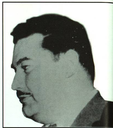
Ing. Antonio Treviño, encargado de las obras de construcción de la FIME en Ciudad Universitaria.
