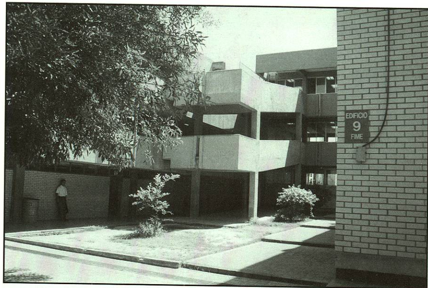
Edificio de Aulas 9
