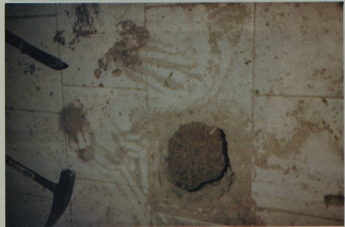
Una toma de muestra de suelo en el interior de una de las casas supuestamente afectadas.
