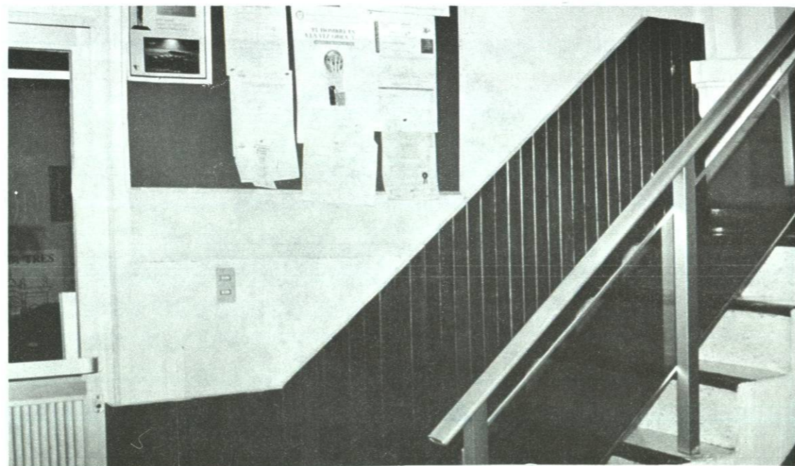
Aspecto de la remodelación de la recepción de la Dirección Escolar y acceso al área de asesorías del Sistema Abierto.
