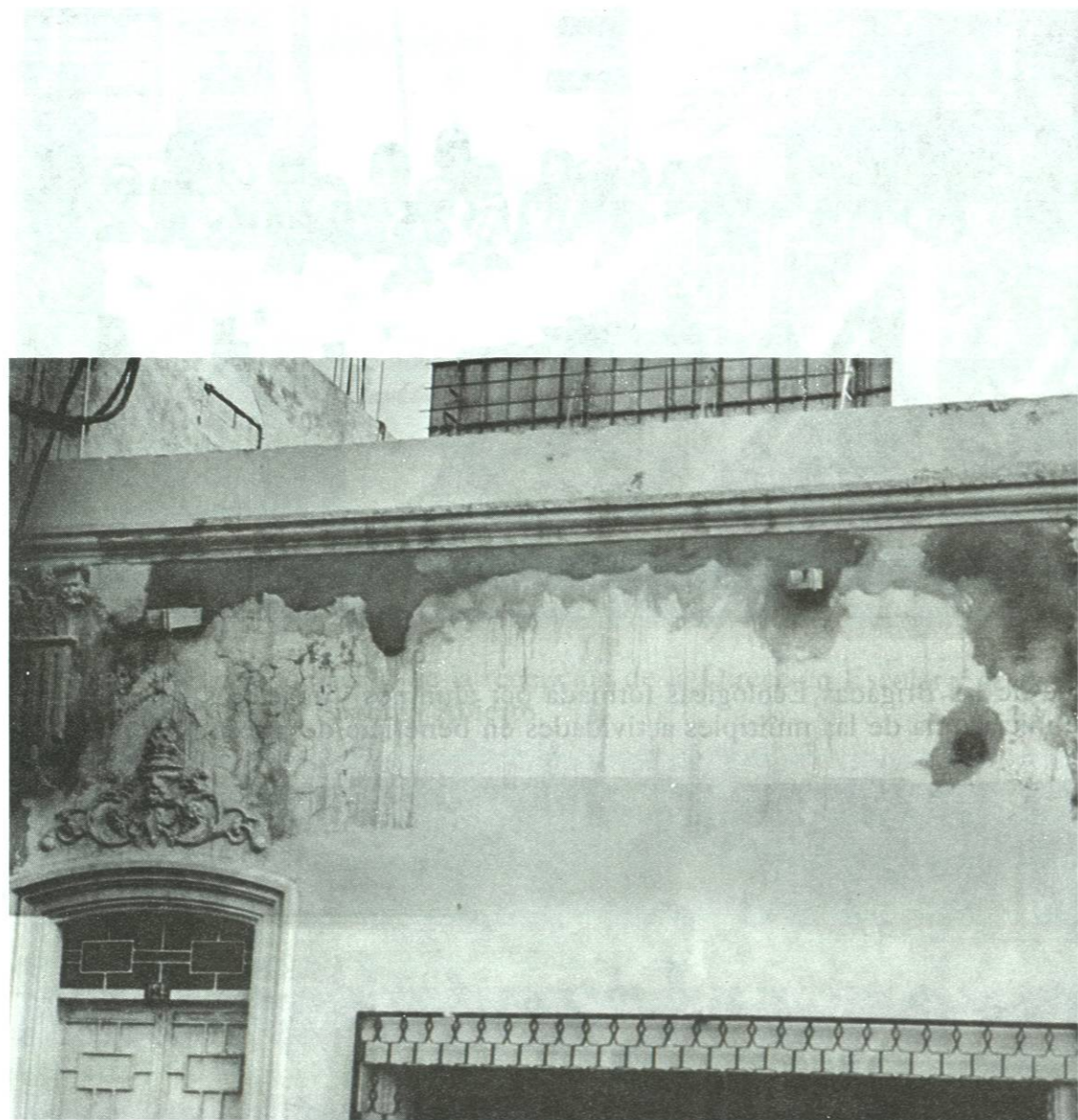
El local que ocupa la imprenta escolar de nuestra preparatoria fue objeto de constante mantenimiento y reparación.
