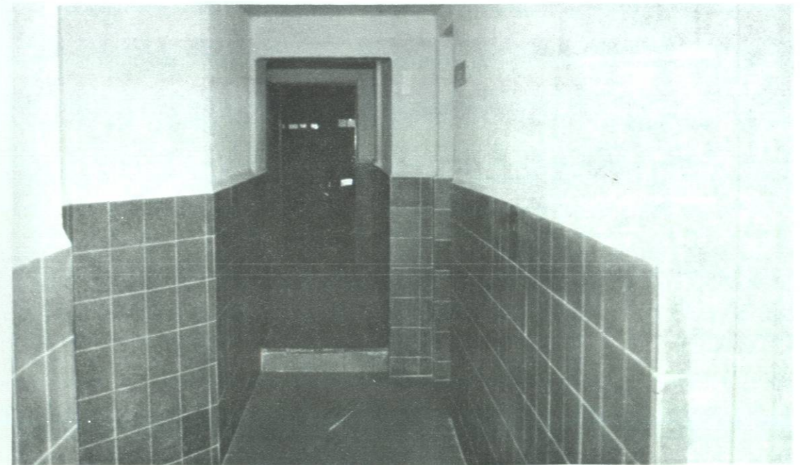
Remodelación del pasillo de acceso del estacionamiento a la planta baja norte del edificio escolar.
