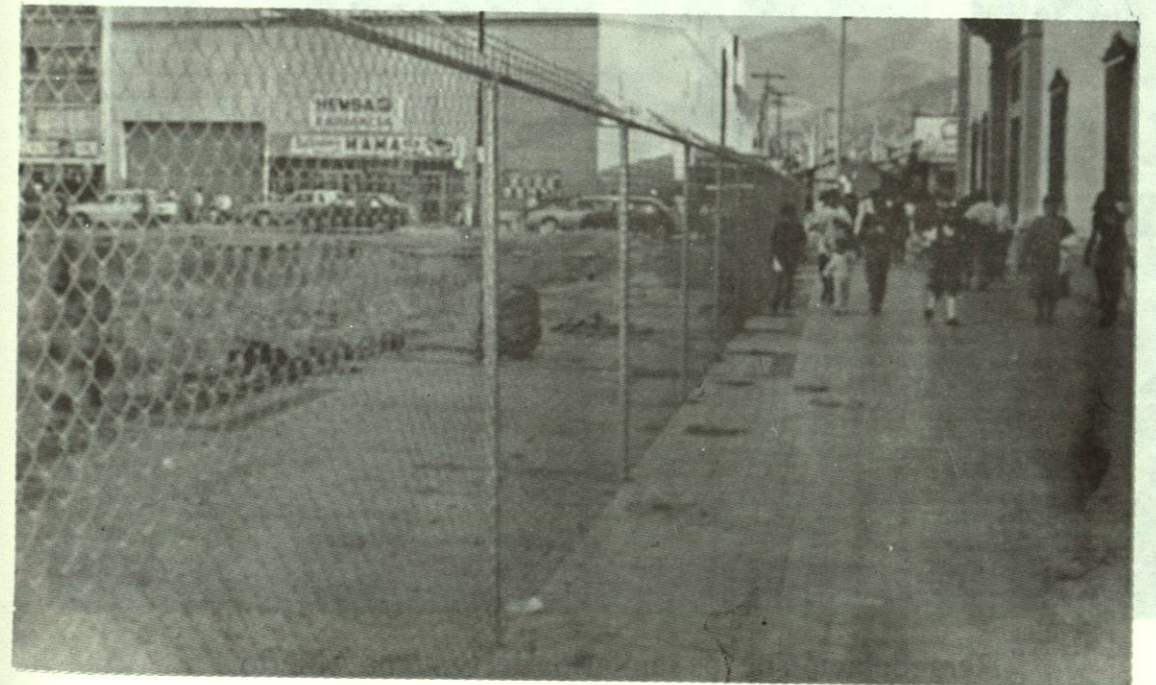
Instalación de malla ciclónica en la Plaza del Colegio Civil.
