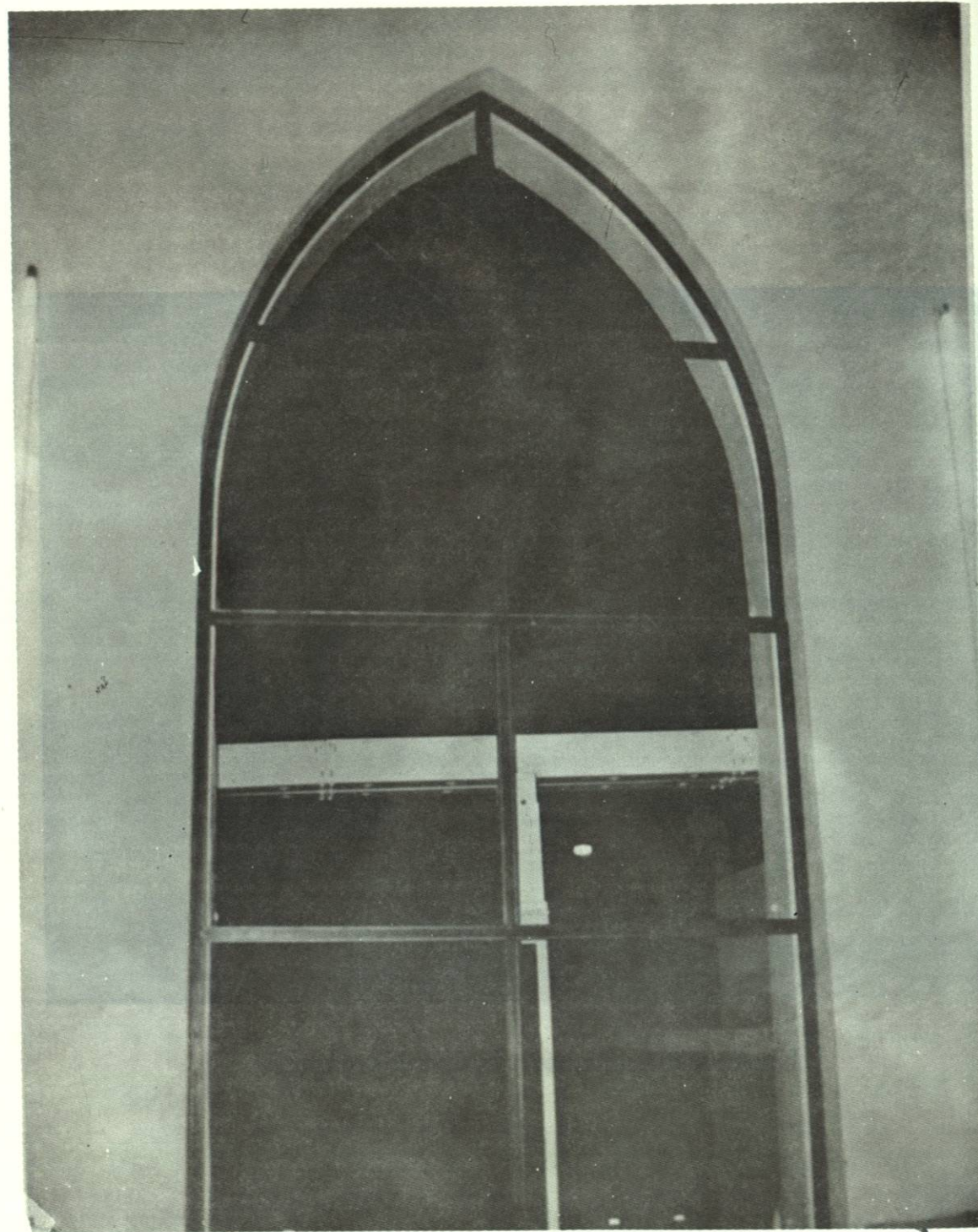
Inicio de los trabajos para instalar el vitral en el lado norte de edificio.
