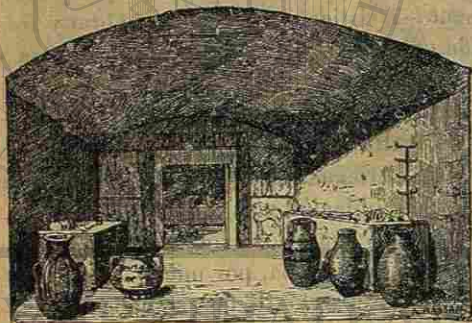
Interior de la gruta Campana.
