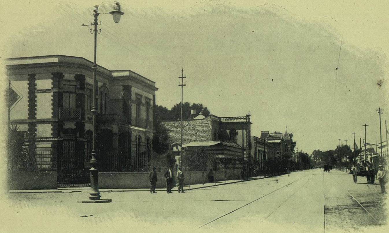
Colonia de los Arquitectos en la Ciudad de México.
