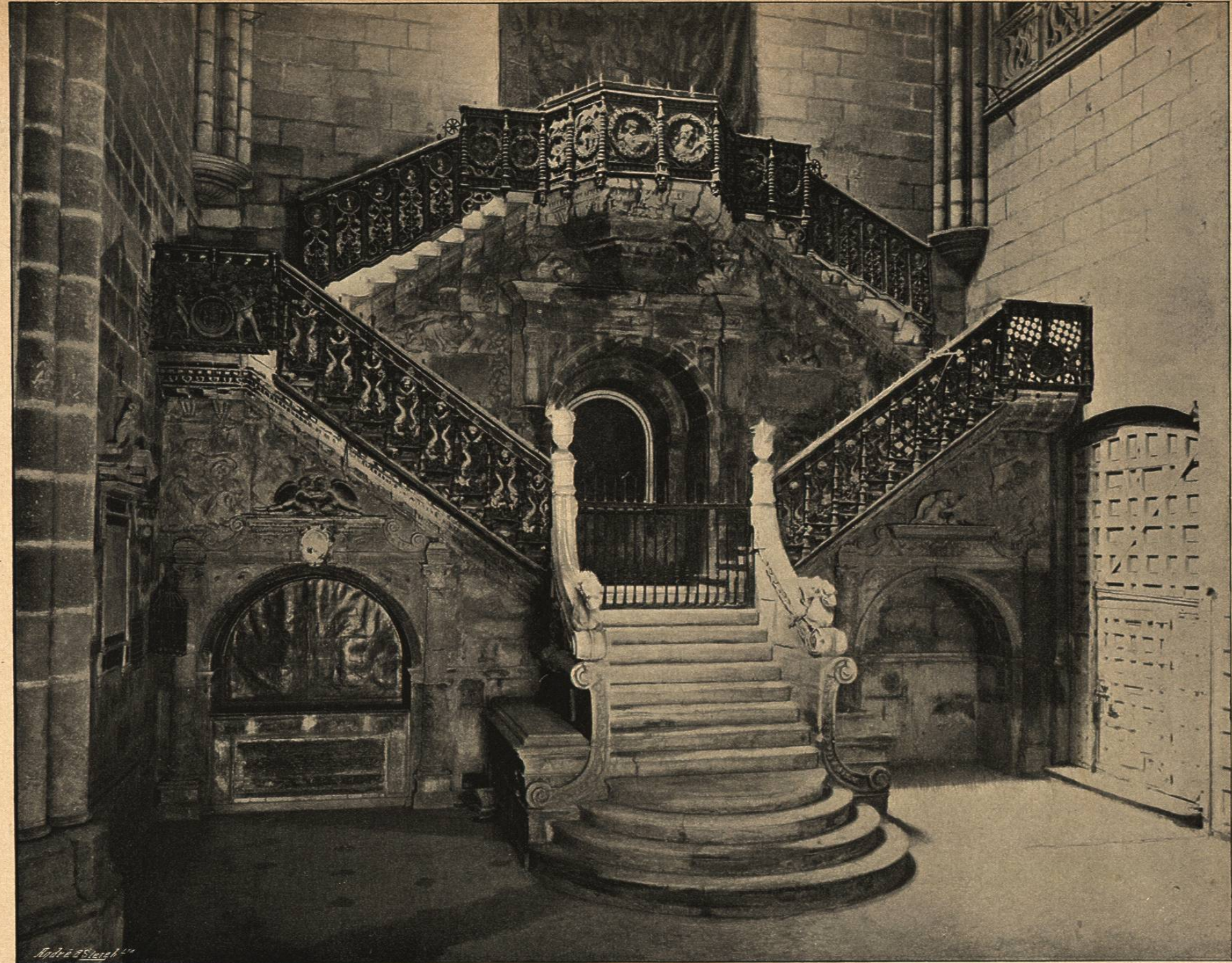
ESCALERA DE LA PUERTA ALTA DE LA CATEDRAL DE BURGOS
