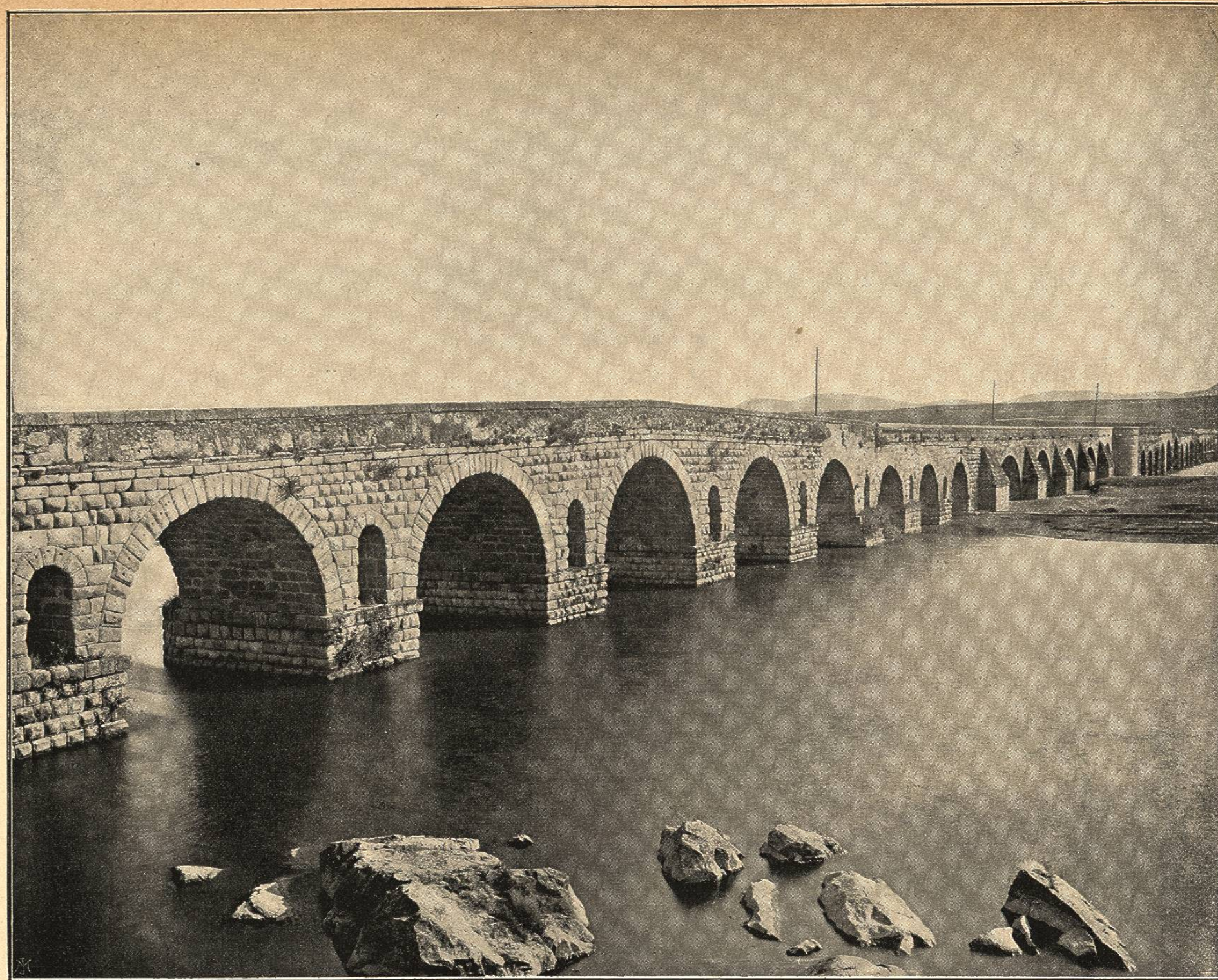
PUENTE ROMANO EN MÉRIDA
