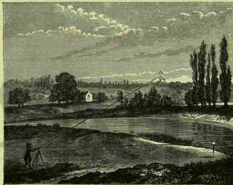
Fig. 128. — Medida de la distancia que separa un punto de otro punto inaccesible
