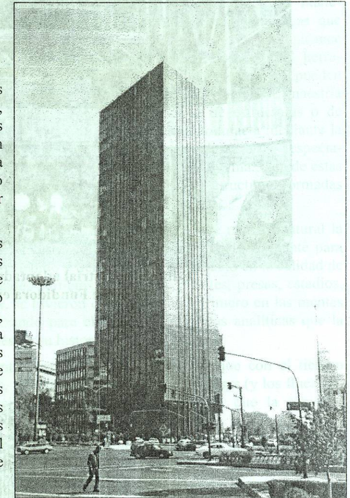
Edificio de la Lotería Nacional, México, D.F
