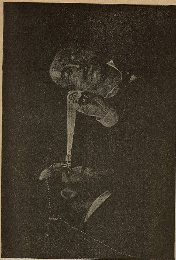
Fig. 173. — Photophore électrique frontal de MM. Hélot et Trouvé. Dernier modèle. Le dessin le représente employé comme otoscope.
