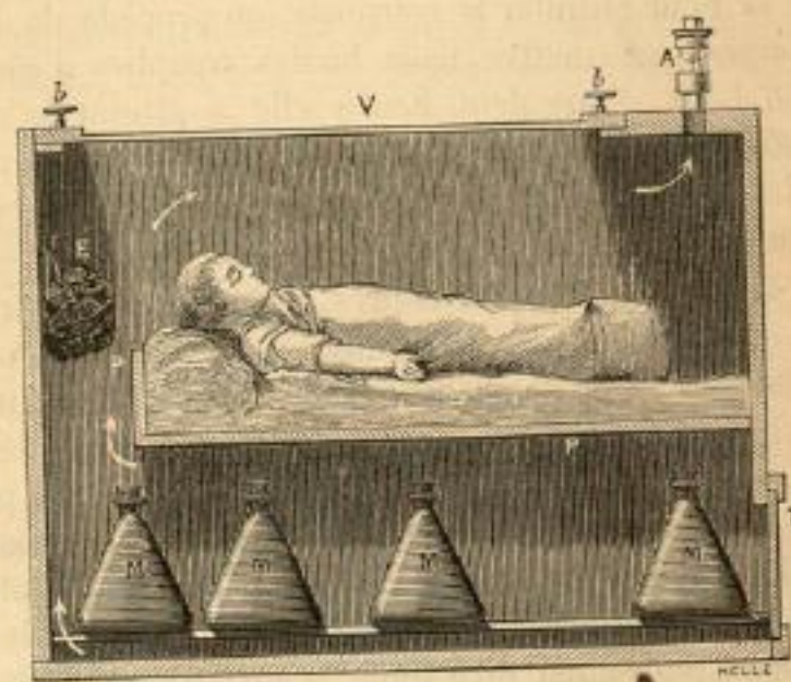
Fig. 585. — Couveuse Tarnier se chauffant avec des boules.
