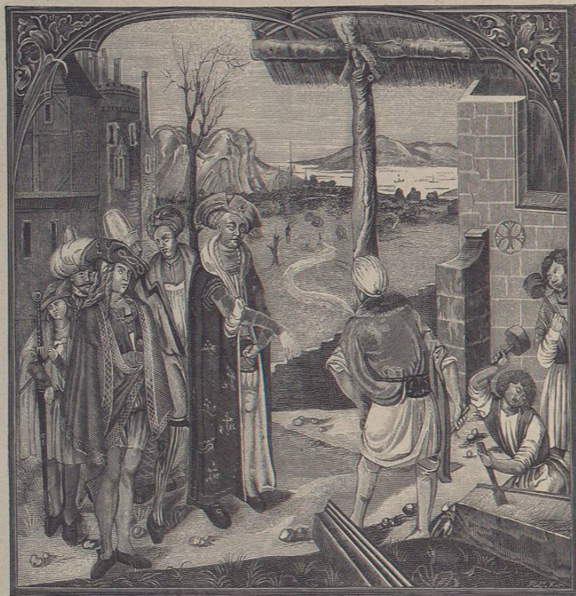
Escenas de la vida eclesiástica en Polonia durante el siglo xv. - 1. Construcción de una iglesia.
