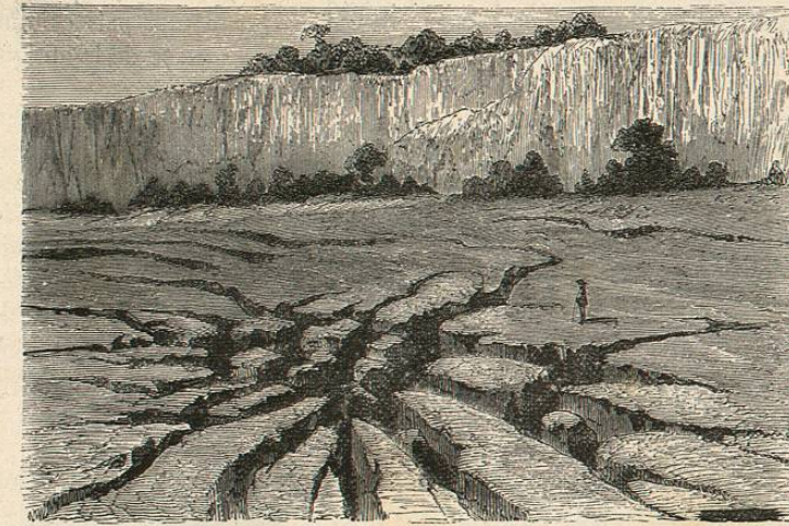
Fig. 13.—Grieta cerca de Jerocarne
