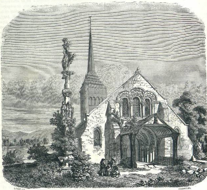
Vista de la iglesia de Lery.
