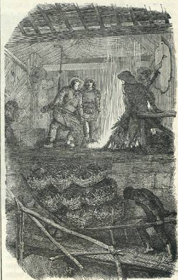
Carga del mineral y del carbon por la boca del horno.
