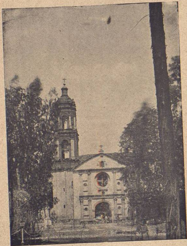
Fachada de la Iglesia del Hospital de Sta. Fe de México. (Estado actual.)
