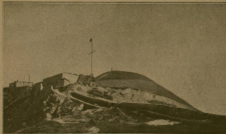
Port-Arthur: fuerte de la señal
