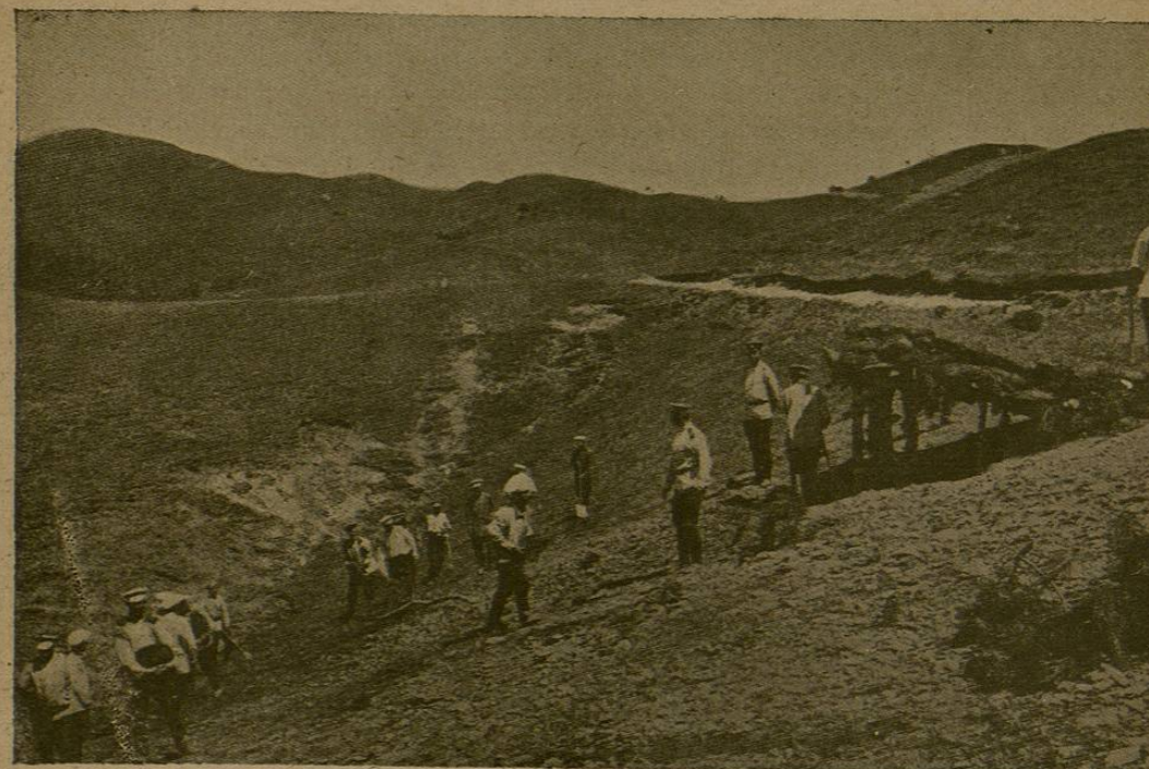
Construcción de abrigos á prueba en las líneas de Liao-Yang
