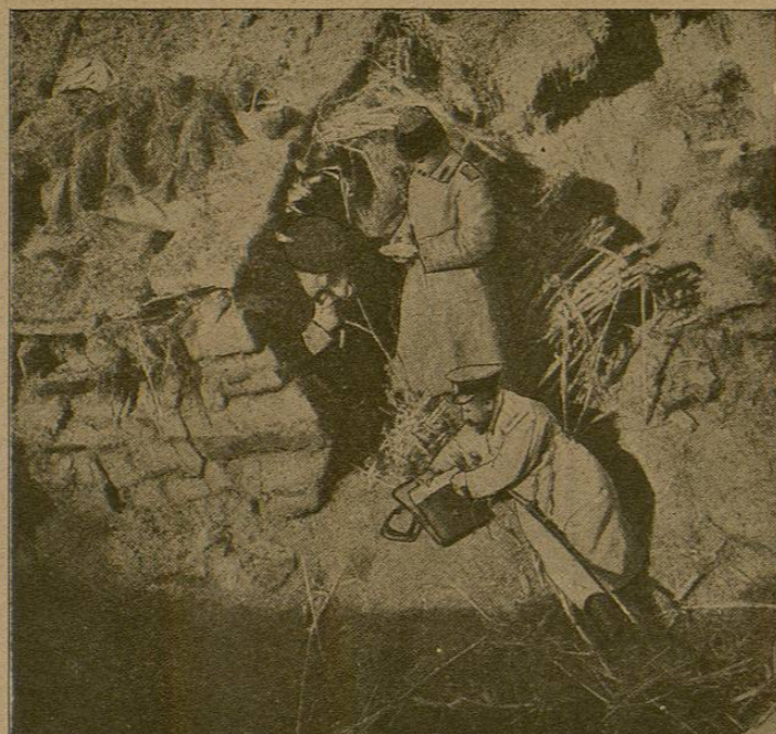
Estación telefónica en las líneas del Sha
