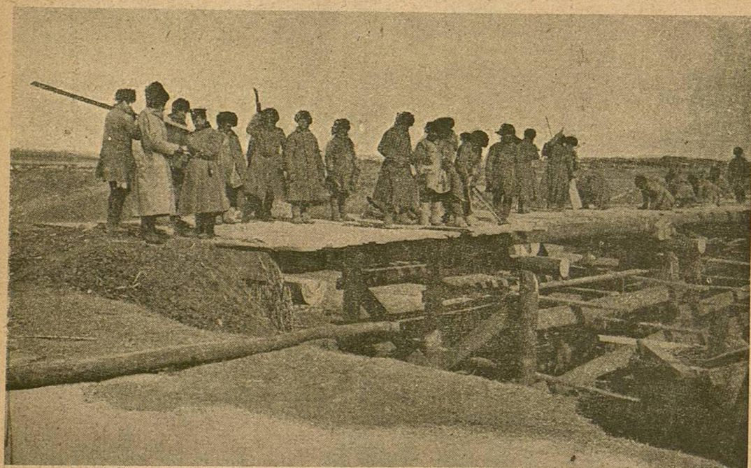
Construcción de un puente cerca de Kan-do-li-san
