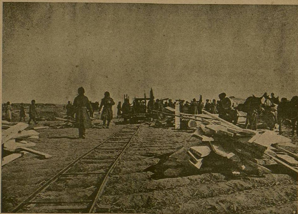
Ingenieros rusos tendiendo un ramal de vía férrea en Kan-do-li-san
